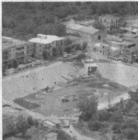
Uno dei Regi Lagni Borbonici a Sarno, progettati come camere di decompressione e attenuazione del flusso delle acque in condizioni di emergenza
